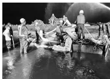
▲姥堂川への排水現場
