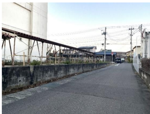
写真①（敷地境界東側の高低差）
