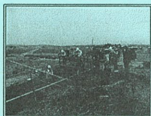
大深沢川と交差する サイホン
