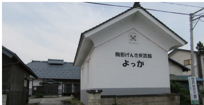
活動拠点となる「駒形げんき交流館『よっか』」です。目印となるものがなかったので蔵に大きく名前シールを貼り付けました。
