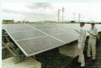
太陽発電設備の検査の様子
