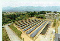
リユース品を使用した発電所
