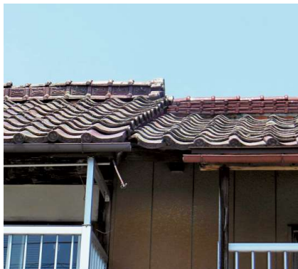
棟廻りの瓦 左：箱形に組む形式 右：雁振瓦を伏せる形式
