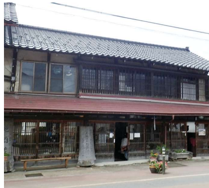
本屋根が瓦葺、下屋が金属板葺の事例
