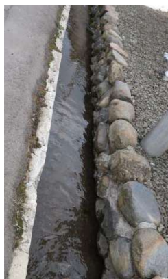
水路：玉石積み
