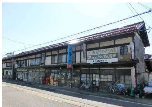
遠藤家住宅：長屋（切妻平入：昭和7年）
