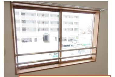
⑪手すりの設置 転落防止対策
