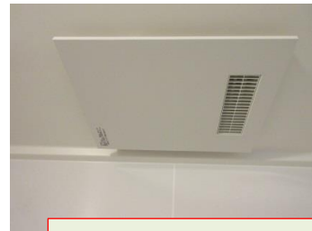
④浴室暖房換気扇 の設置 ヒートショック防止 屋内洗濯干しの確保
