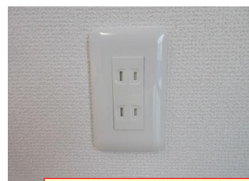
⑨扉付きコンセント の採用 子どもの感電防止
