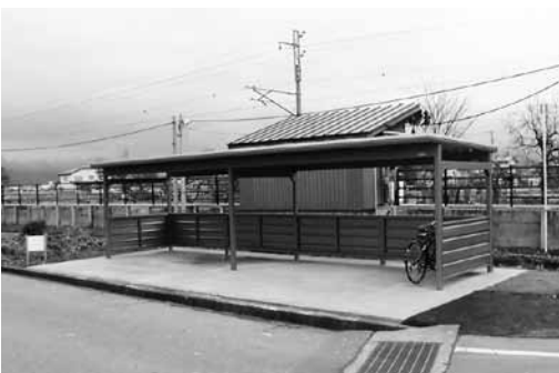
▲完成した豊川駅駐輪場
