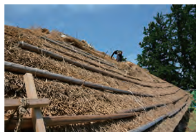
勝福寺観音堂の茅葺屋根の葺替修理
