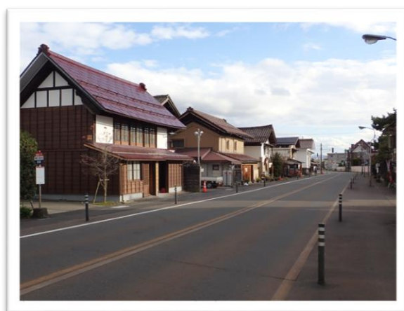
町並み（南町の無電柱化）
