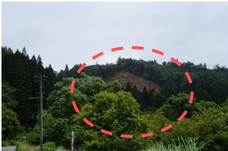
令和元年5月 市内で土砂崩落が発生
