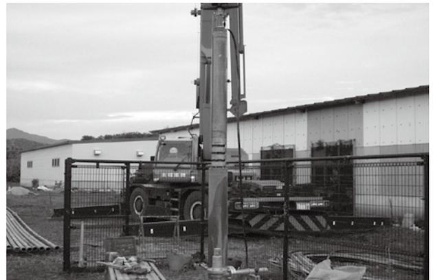
熱塩加納保健センター保養施設「夢の森」の源泉井戸である大森温泉の揚湯管及びポンプの破損による入替工事、予備ポンプの購入など。
