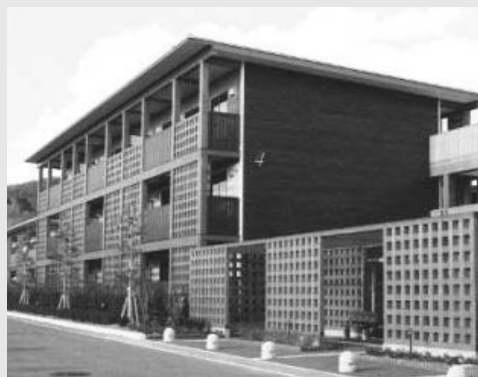
▲子育て世帯向け定住促進住宅（県営住宅の例）
