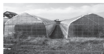
【事業名】 元気な産地づくり整備事業補助金 【事業費】 450.2 万円 【内 容】 まだ施設化していないアスパラ生産者に対し、パイプハウス等の整備事業を助成する。
