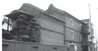
【事業名】 蔵等国登録有形文化財保存支援事業補助金 【事業費】 332.3 万円 【内 容】 雪害により屋根等の修復が必要な国登録有形文化財に対して修繕費を助成する。
