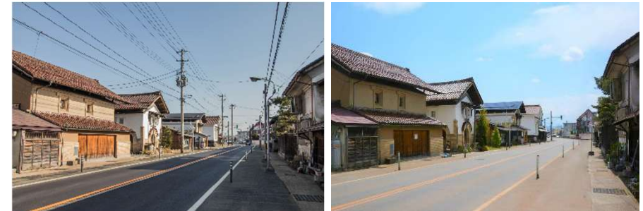
無電柱化による景観整備の効果
