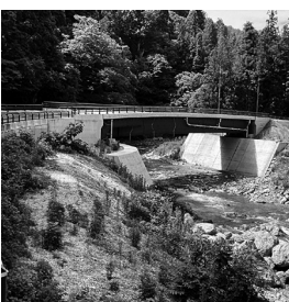
▲完成した一ノ俣橋
