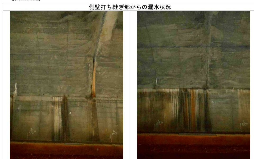
図表 6.2-2 : 現況漏水状況
