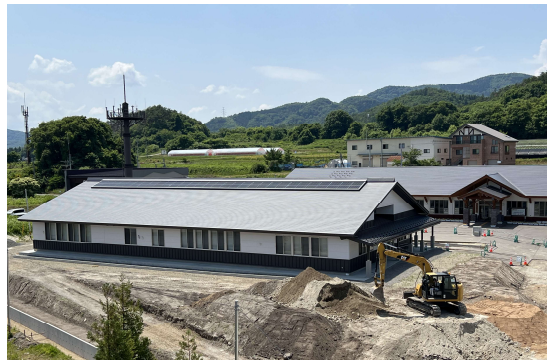
外構工事が進められています
