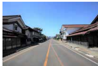
小田付伝統的建造物群保存地区
