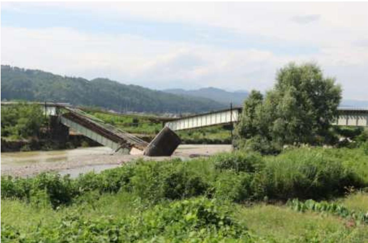
図 1-8 崩落したJR磐越西線の濁川橋梁
