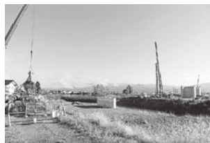
▲ 豊川・慶徳線建設工事の様子
