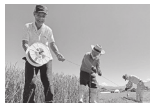
▲ 電気柵を設置している様子
