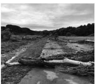
▲山都町舟岡地区の被災状況
