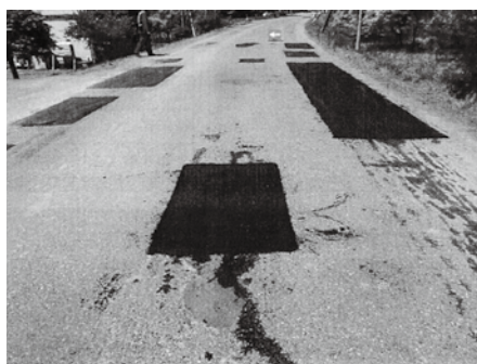
▲アスファルト舗装パッチング
