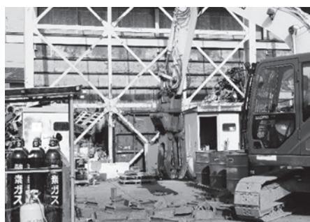
▲ 鋼材を機械で加工する様子
