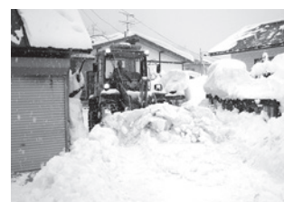
▲除雪車両と除雪作業(土木費)
