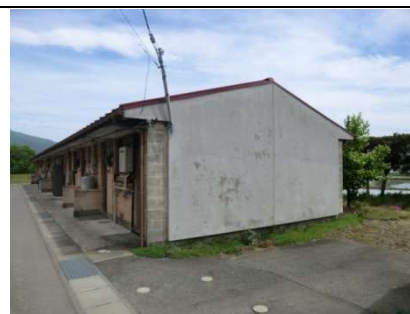
外壁の状況 (簡1)
