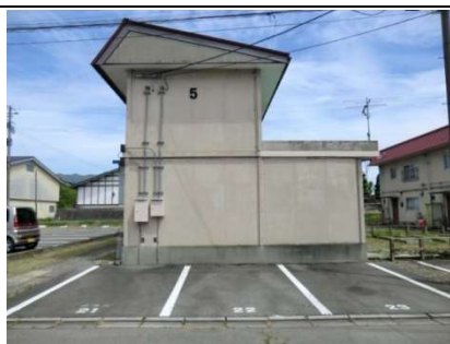
外壁の状況①
