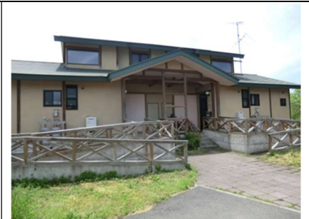
スロープ設置住戸
