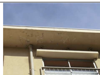
軒裏の状況①
